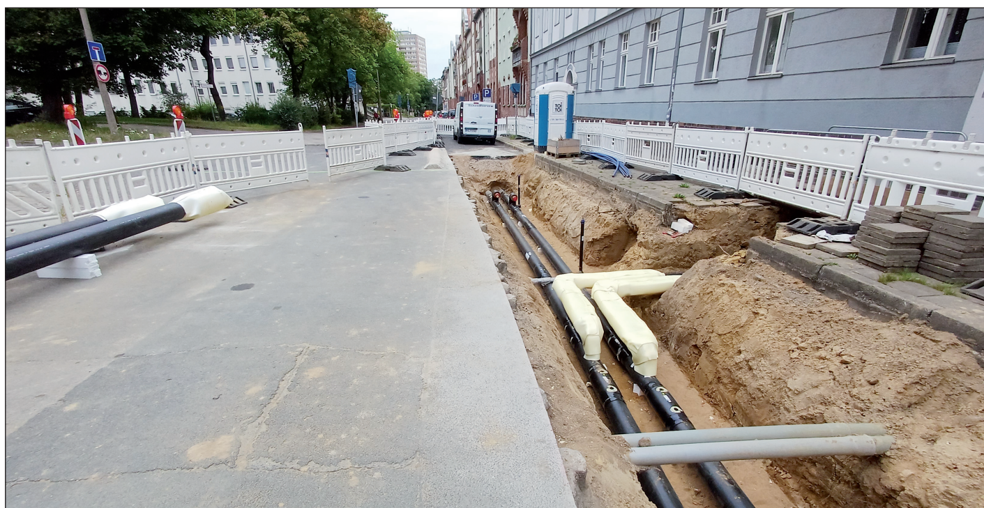
Baustelle im Bereich Kleistpark.
