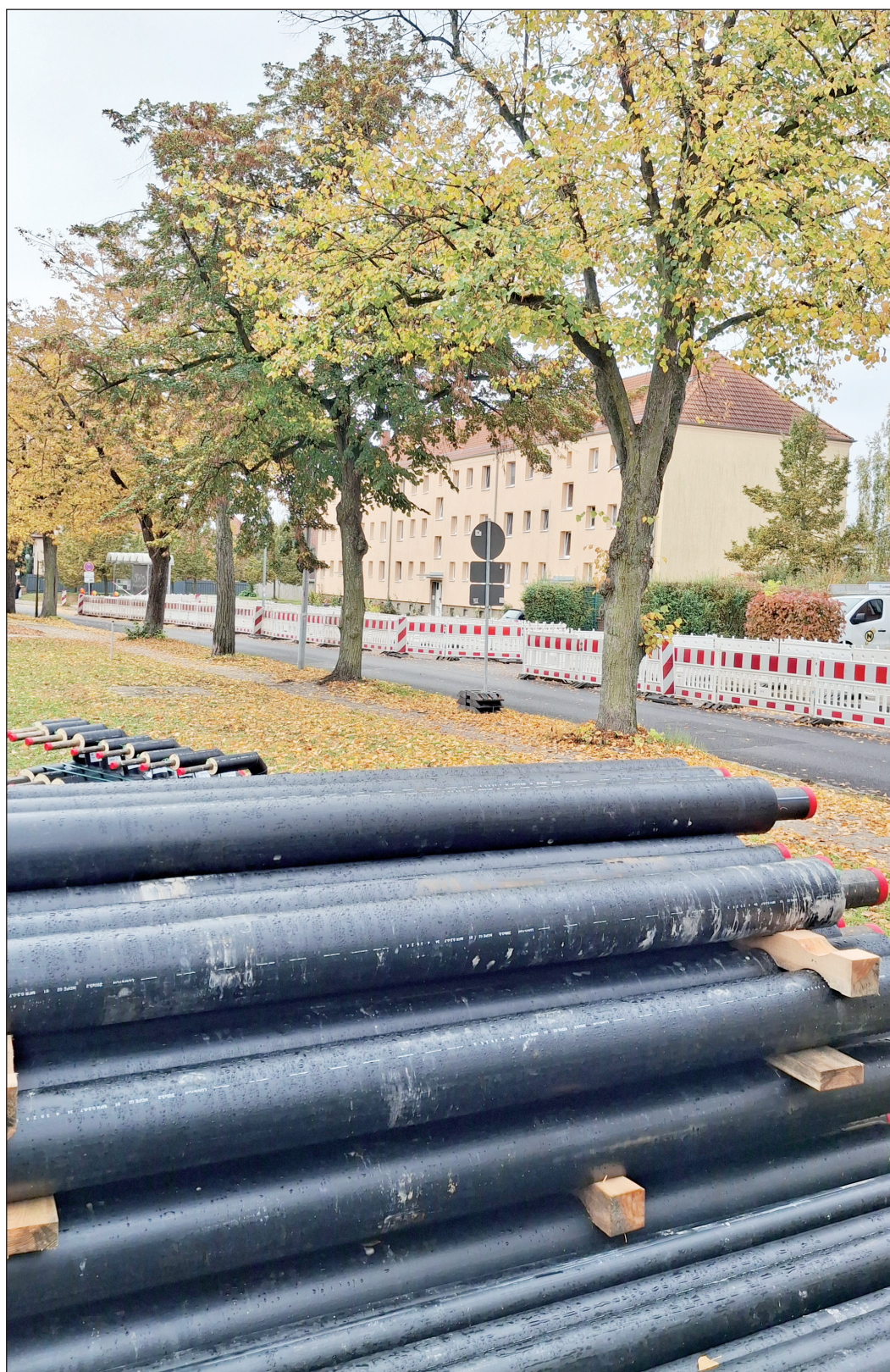
Netzausbau in der Lennéstraße.
