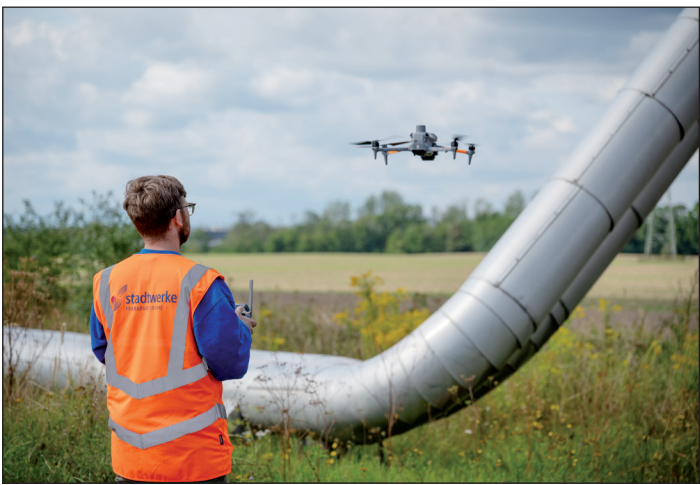
Wärmebilddrohne im Einsatz.
